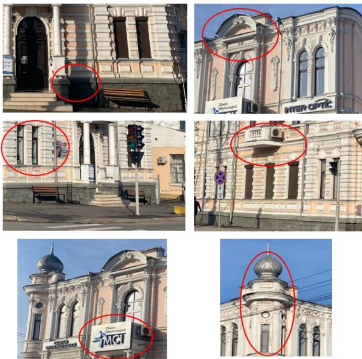
Fig. 3. Fațada inspectată a monumentului istoric de pe str. București 106A, Chișinău, Republica Moldova, 2021
