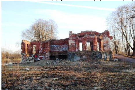
Рис. 4. Состояние павильона, фото 2017 г.
