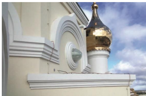
Рис.12 Трубчатый светодиод на фасаде
