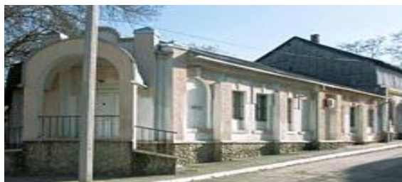
Brutărie str. Cojocarilor 19
