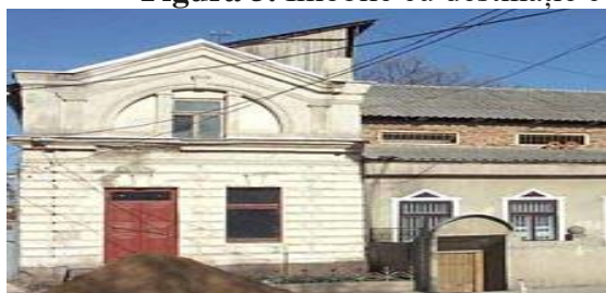
Imobil depozit str. Al. cel Bun 24
