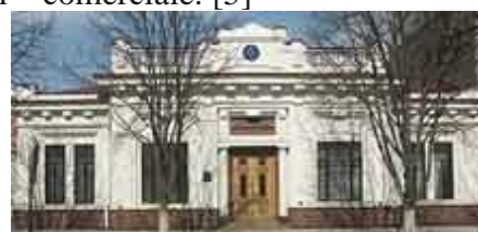
Fosta bancă str. Vlaicu Pîrcălab 55 B
