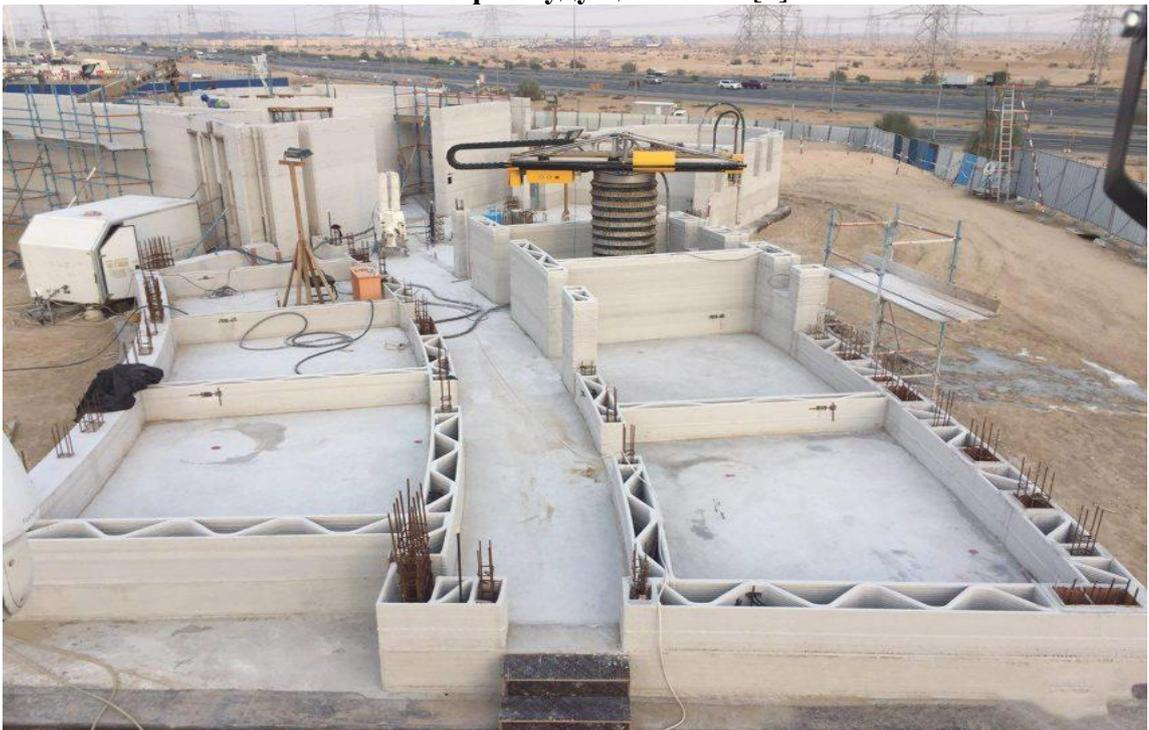
Рис. 4. Офисное здание, напечатанное на 3D-принтере [5]
