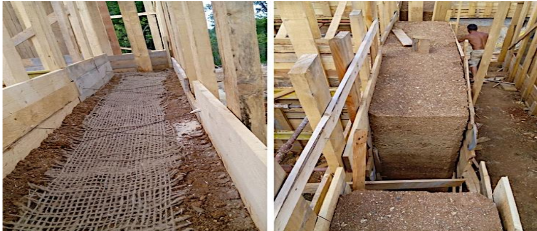
Figura 4. Metoda de cofrare cu pământ crud [3]
