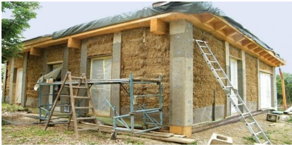
Figura 3. Construcția unei case din baloți de paie [3]
