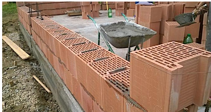
Figura 5. Zidăria pereților cu cărămidă [3]
