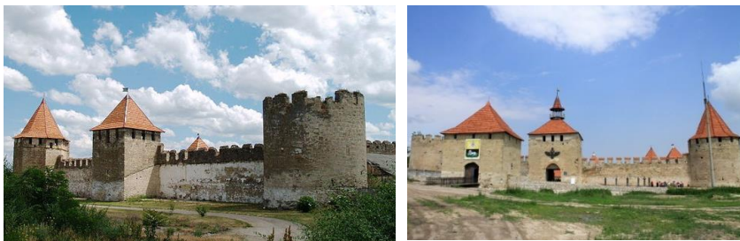
Figura 2. Reabilitarea cetății din Tighina (Bender)
