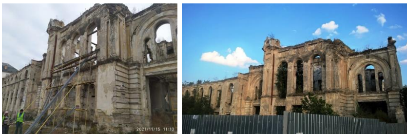
Figura 3. Pregătiri pentru lucrările de restaurare a Sinagogii Rabbi Țirilson
