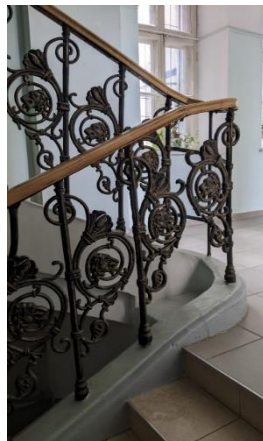
Foto L. Platon Figura 25. Scara veche cu baluștri din fontă.
